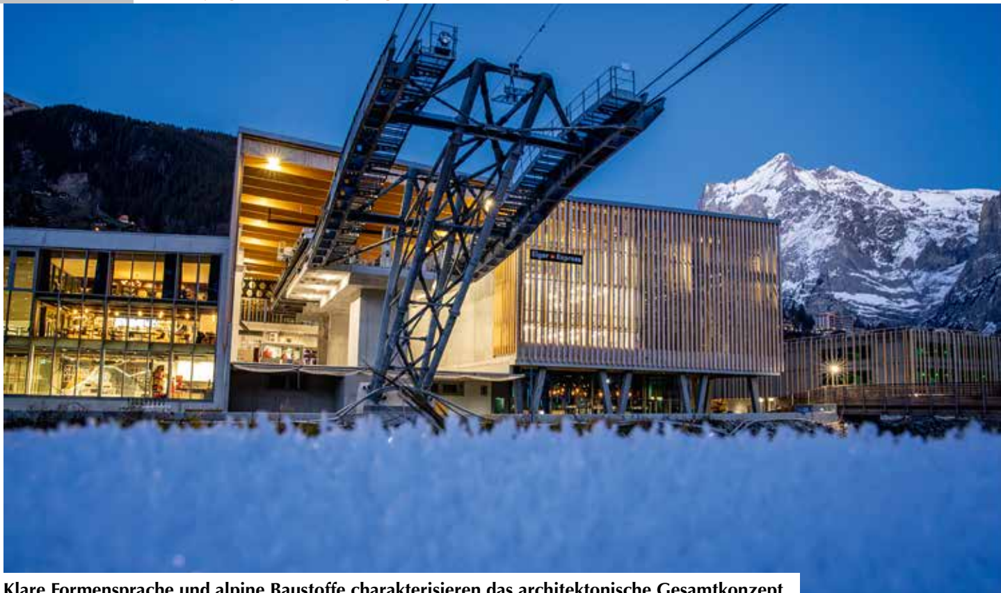
Klare Formensprache und alpine Baustoffe charakterisieren das architektonische Gesamtkonzept.
